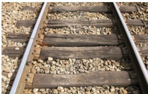
Rails courts sur traverses bois
