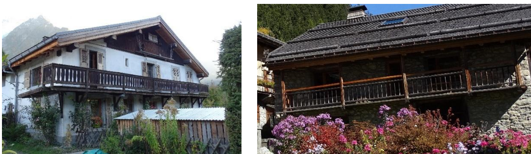
Exemples de balcons filants dans l'architecture rurale
