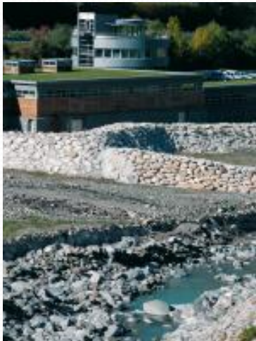
Station d'épuration des Trabets
